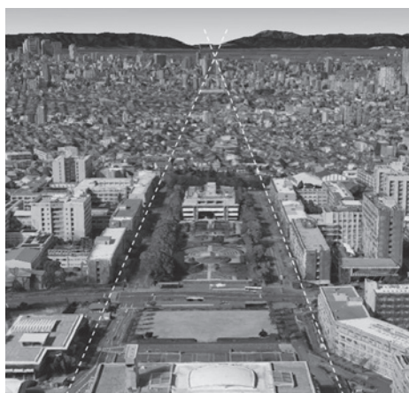
Google Earthによる眺望の分析 (手前：豊田講堂 左手：旧古川図書館 前方：新図書館)
