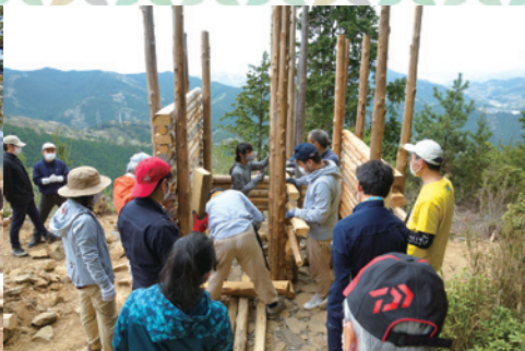
第2回目現地製作会にて壁丸太組工事
