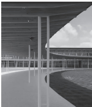
「大野町道の駅」回廊部
