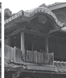
屋根神様(那古野一丁目) 社殿形式は唐破風造り
