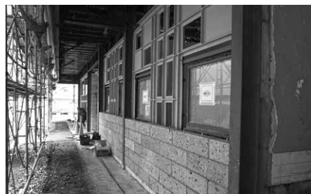
ISGW 工法による壁補強
