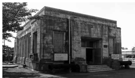
小鷹野浄水場旧ポンプ室(現・薬品注入機室)南東外観
