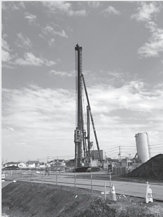
杭工事の様子
