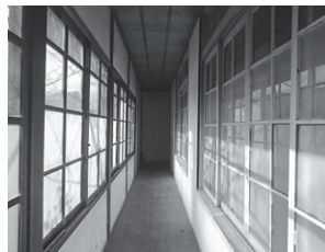
下屋廊下内観
