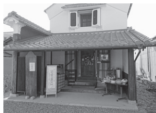
裏庭の土蔵 ガラリとして使われている
