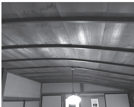
吉島家の湾曲した天井仕上げ
