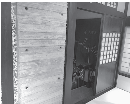
惣四郎のコンクリート仕切り壁
